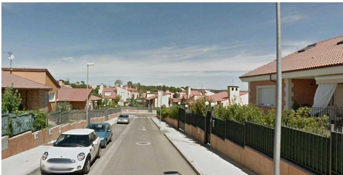
Figura 78. Infraestructura peatonal urbanización Costaján
