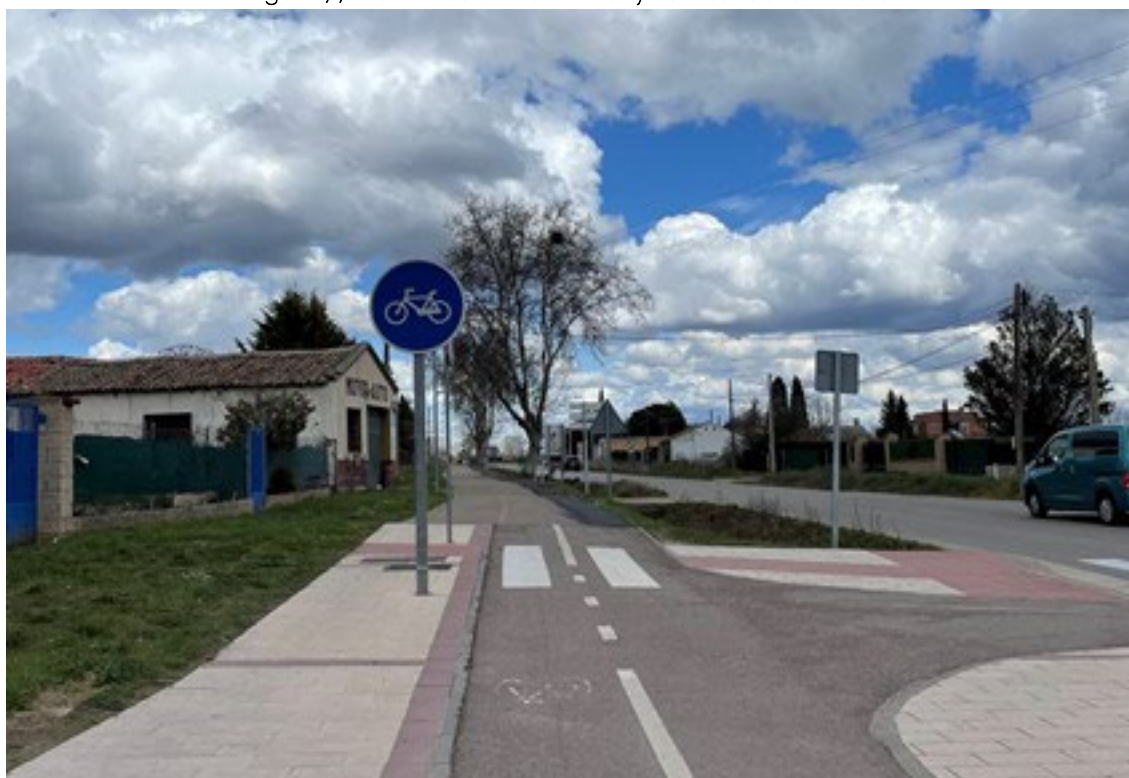
Figura 77. Señalización horizontal y vertical del carril bici.
