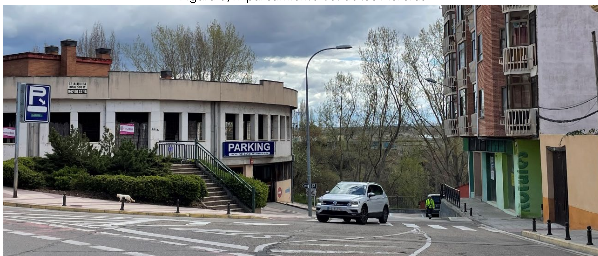
Figura 67. Aparcamiento Sol de las Moreras
