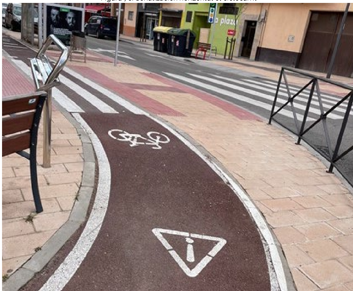
Figura 76. Señalización horizontal el ciclocarril
